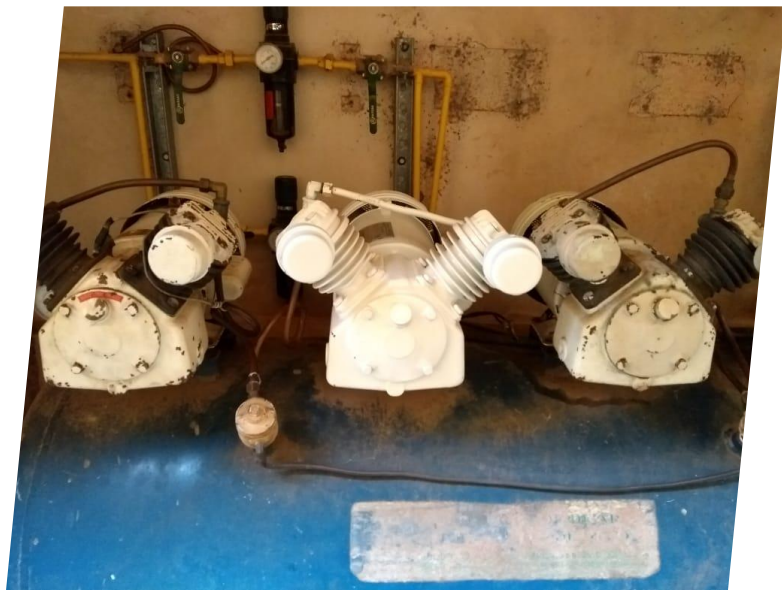
Compressor de Ar Comprimido
