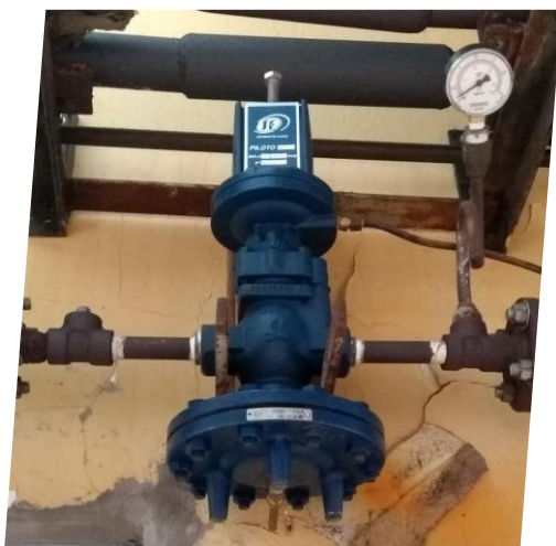
Válvula da Caldeira de Vapor
