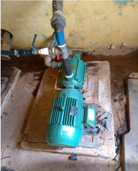
Bombas d'agua Custo: R$ 10.220,46
